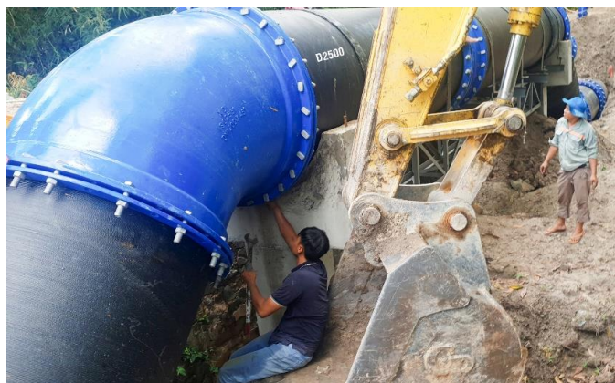
Lắp đặt đường ống nước thô D2500
